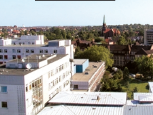
Rechenzentrum: Das Klinikum Kiel kodiert mit einer eigenen Software
